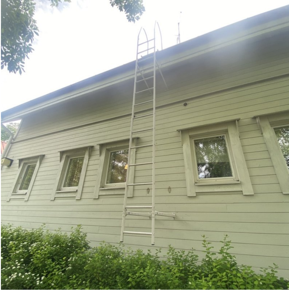
3. Yleiskuva: Seinätikkaiden asennuksessa ja kunnossa ei havaittu puutteita.
