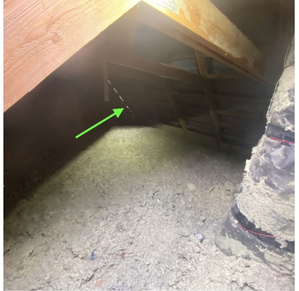
4. Yleiskuva: Yläpohjan tuuletuksen toiminnan edellytyksissä ei havaittu puutteita kulkuluukulta tarkasteltaessa.
