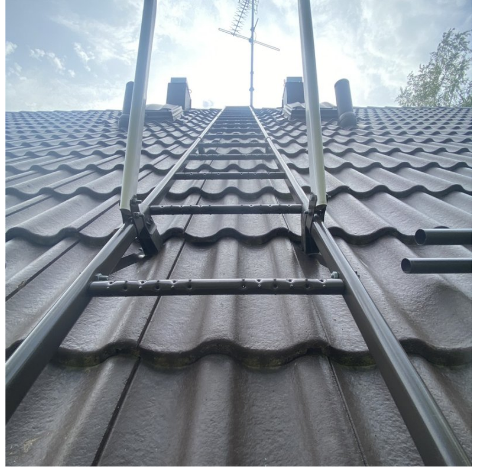
4. Yleiskuva: Vesikatteen huoltotien asennuksessa ja kunnossa ei havaittu puutteita.
