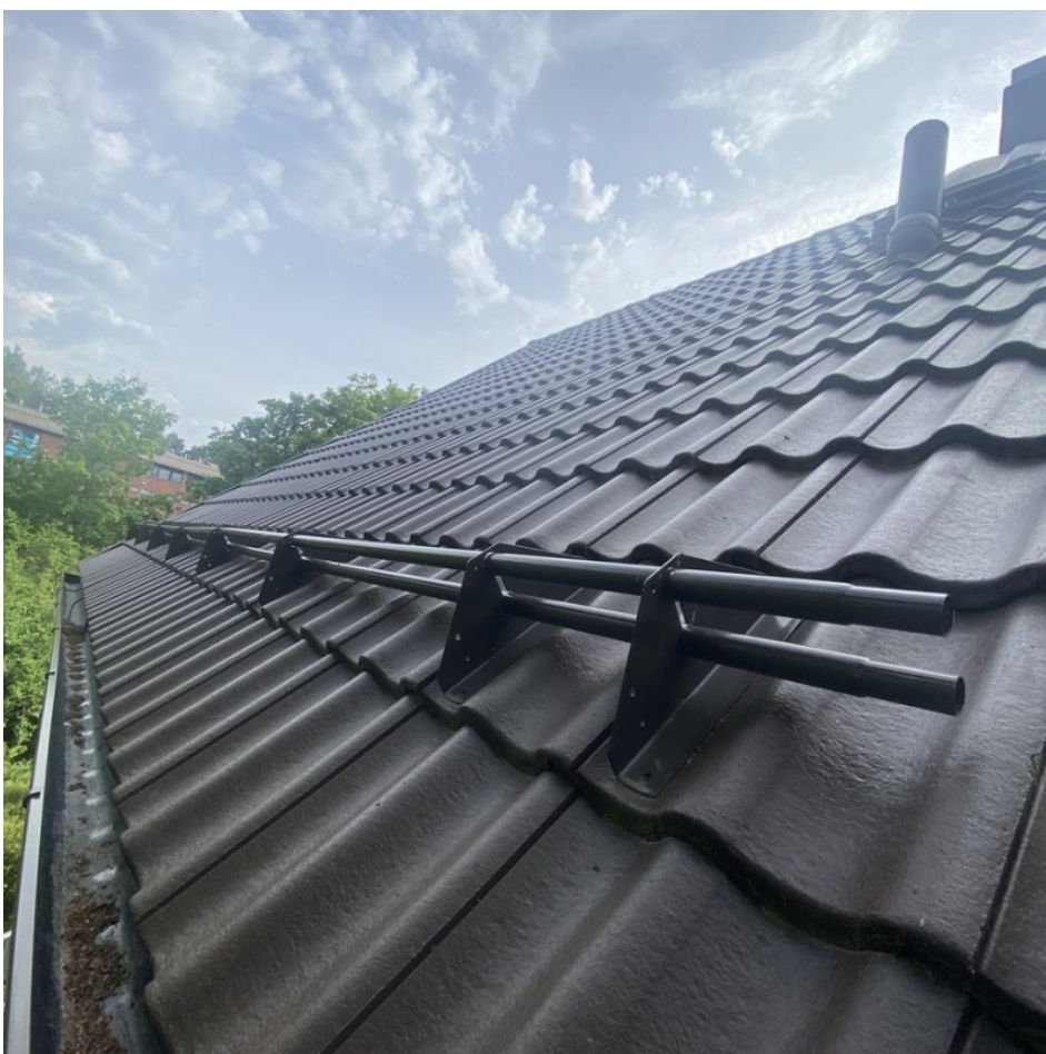
5. Yleiskuva: Vesikaton on asennettu lumiesteet vaadituille kohdille (kulkuväylien ja oleskelualueiden suojaus).
