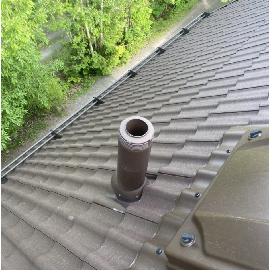
7. Yleiskuva: Vesikatteen läpivientien kunnossa ei havaittu puutteita.
