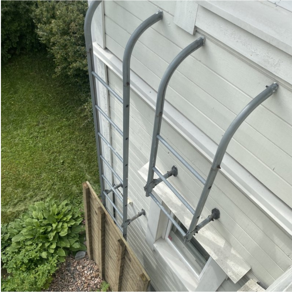
13. Yleiskuva: Yläkerrasta on järjestetty hätäpoistumistie.
