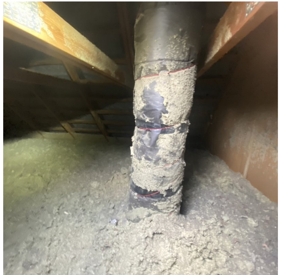
6. Yleiskuva: Ilmanvaihtokanavan (huippuimurin kanava) eristyksessä ei havaittu puutteita.
