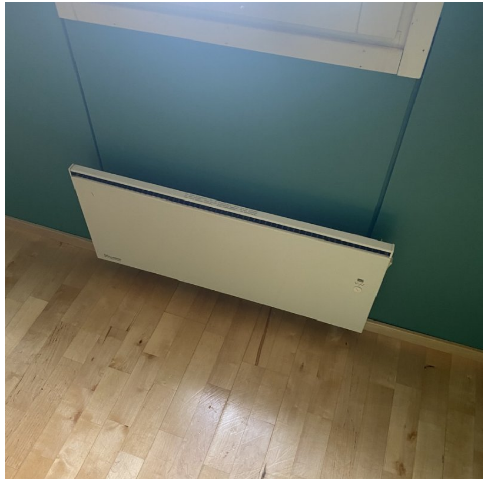
4. Yleiskuva: Sähköpattereiden kunnossa ja asennuksessa ei havaittu puutteita näkyviltä osin.
