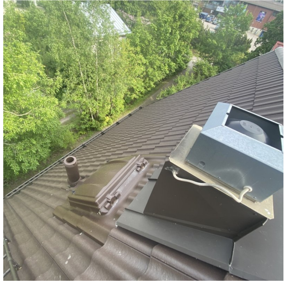
12. Yleiskuva vesikaton läpivienneistä.
