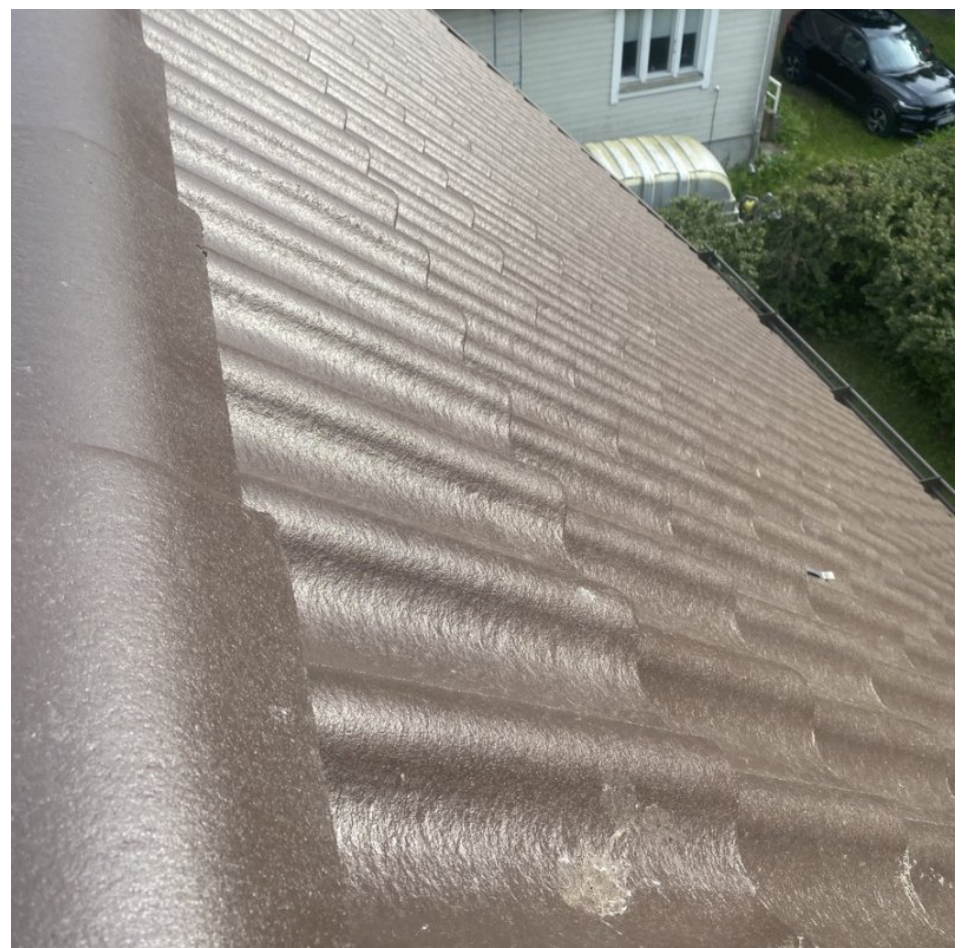
6. Yleiskuva: Katteen pinnoitteen kunnossa ja puhtaudessa ei havaittu puutteita.
