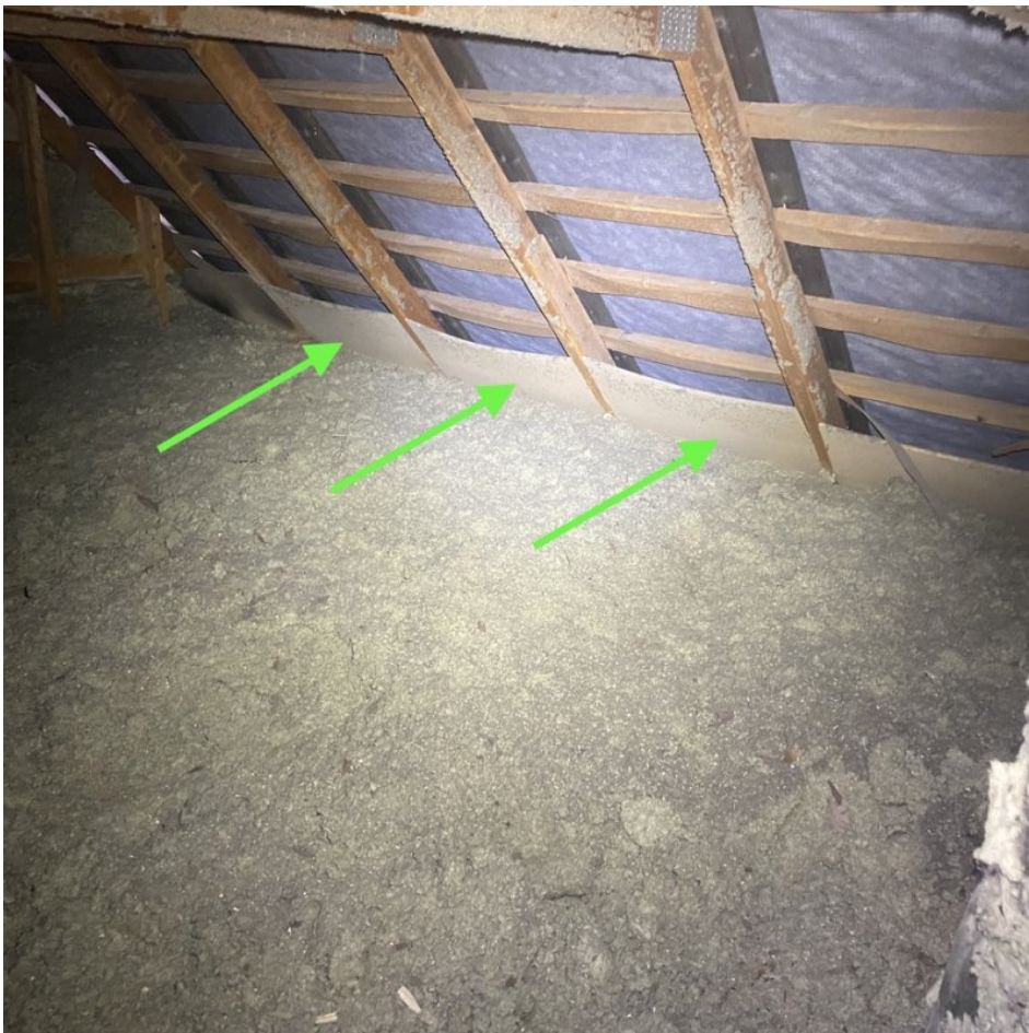
5. Yleiskuva: Tuulenohjaimien asennuksissa ei havaittu puutteita.
