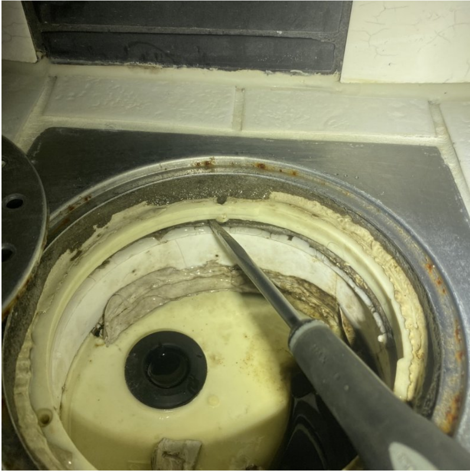
9. Yleiskuva: Lattiakaivosta havaittiin vahvikekangas kiristysrenkaan alta. Lattiakaivon asennus on näkyviltä osin nykyohjeiden mukainen.
